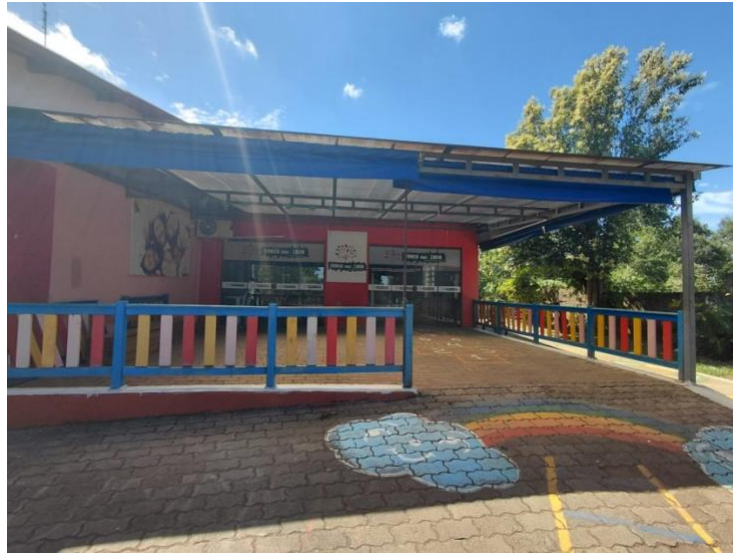
RAMPA DE ACESSO ENTRADA DA ÁREA COBERTA
